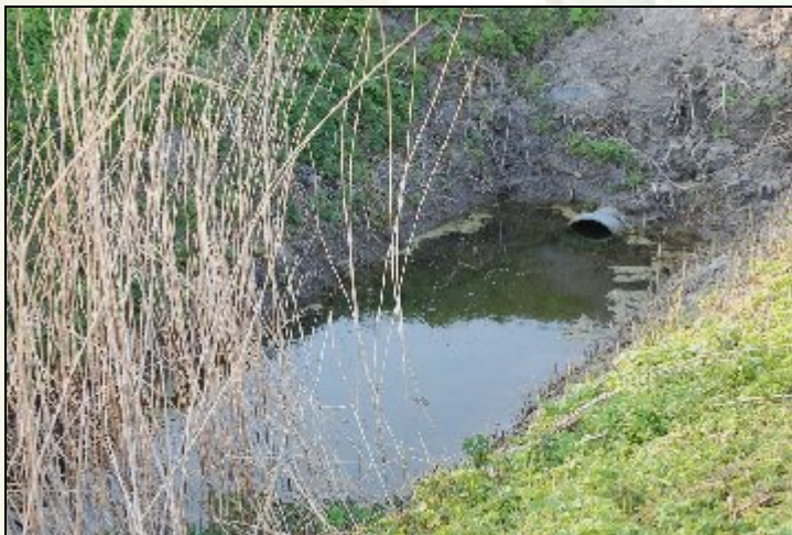
Een vrijgemaakte duiker garandeert de doorstroming in een rietsloot.
