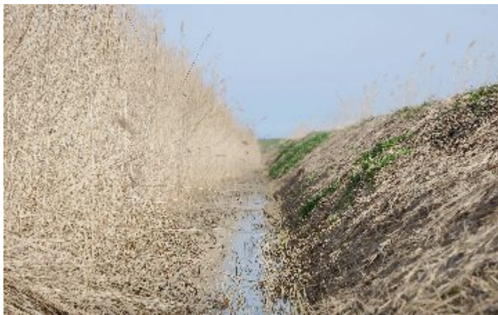
Voorbeeld van de onderhoudsvorm waarbij het oude riet in de helft van de schouwsloot blijft staan.
