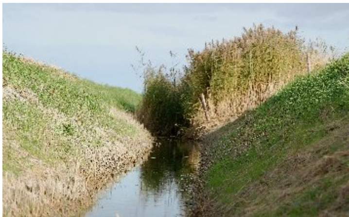
Een schouwsloot met gangbaar onderhoud waarvan een deel van het riet nog niet is gemaaid (oktober 2010). Het riet in de bovenste meter op het linker talud is eerder in de zomer al gemaaid.
